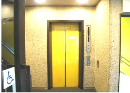
専用エレベーターで3階へ
